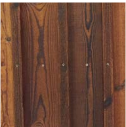
VARMEBEHANDLET TRÆFACADE En holdbar og varmebehandlet træfacade med lodrette brædder.
